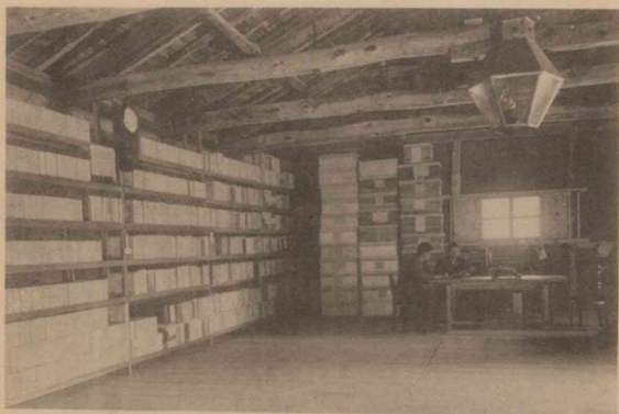
第一號風穴の上第一備豫 第一室內光景
