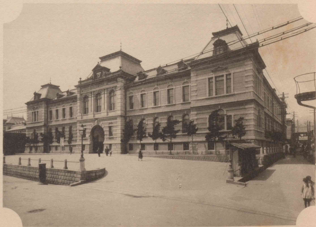
神 戶 市 役 所 Kobe City Office.
