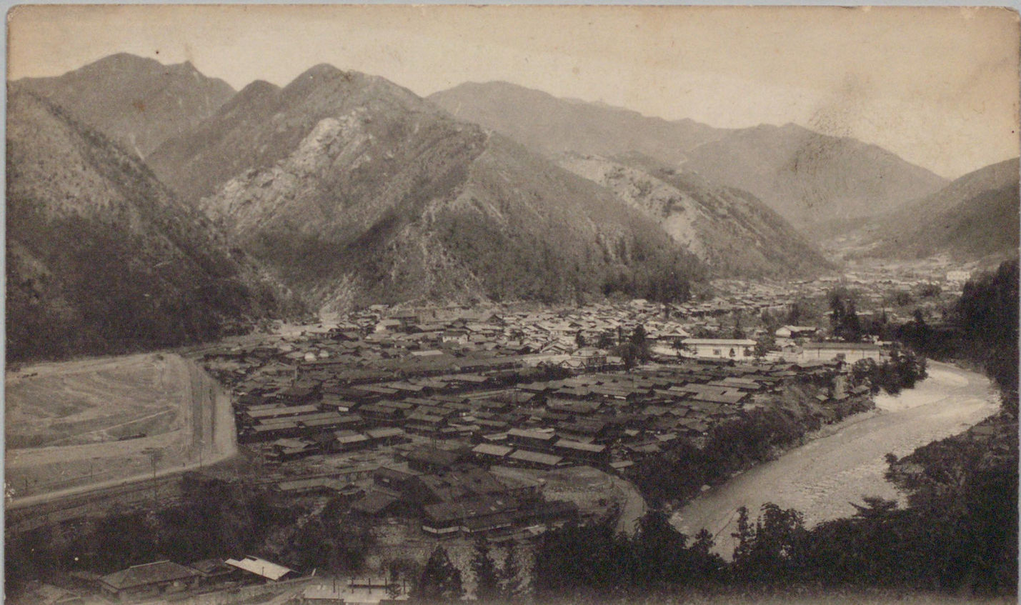
足尾町漏洞全景
